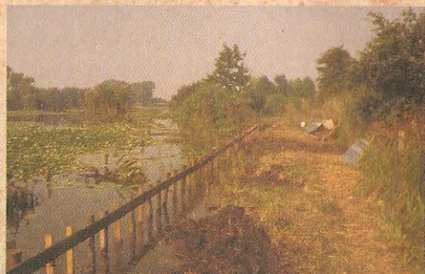
Installation des piquets
