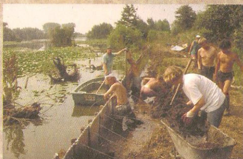
Installation de la tôle
